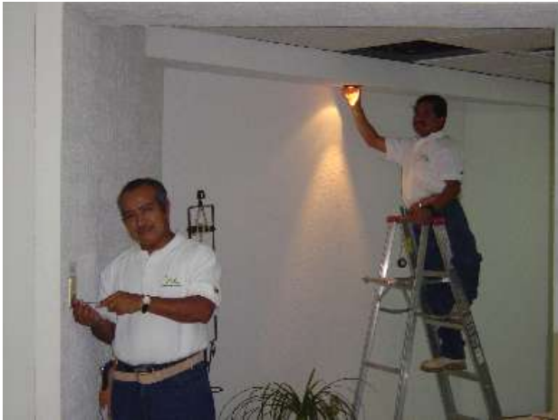
Separación de circuitos y cambio de luminarias en las instalaciones INE.
