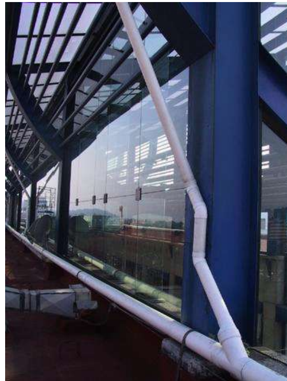
Edificio sede de SEMARNAT.
